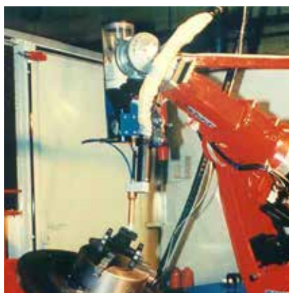
Процесс нанесения покрытия с помощью автоматической установки Eutronic GAP
