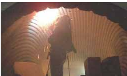
Металлизация теплообменника проволокой EuTronic Arc 595
